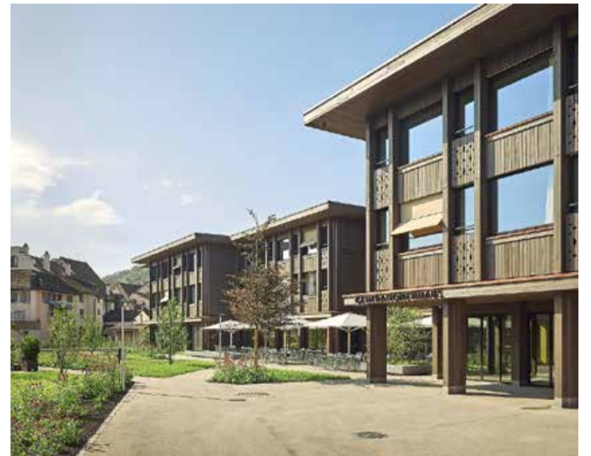
Generationenhaus Bad Zurzach: Zugunsten ihrer Langlebigkeit ist die Fassade aus Weisstanne druckimprägniert (KDS chromfrei mit braunem Farbton). Das grosse Vordach trägt zu ihrem Schutz bei. BILDER ROLAND BERNATH, ZÜRICH
